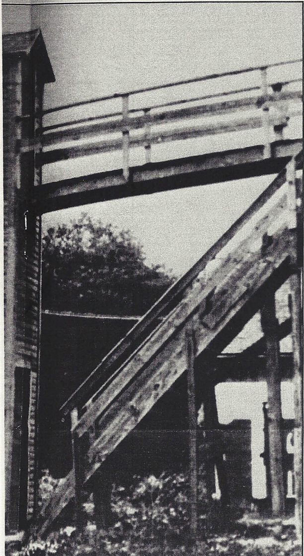
ing house privy.
